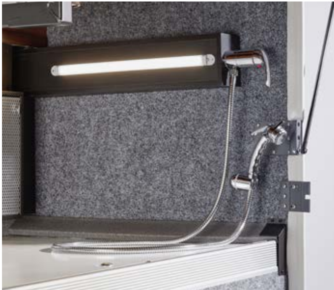
mit Warm- und Kaltwasser in Rollergarage
