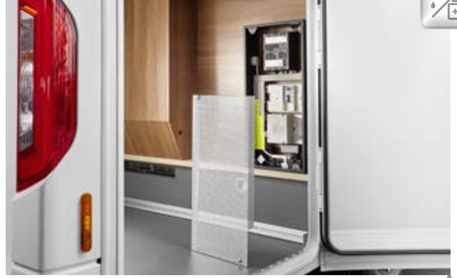
Elektrozentrale in der Rollergarage gut zugänglich
