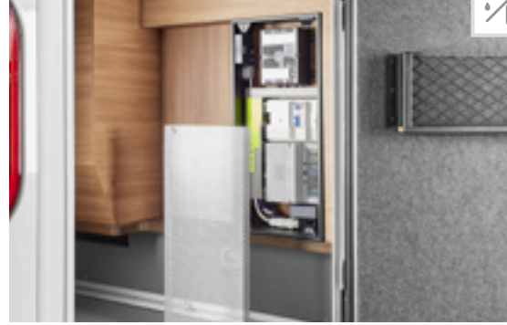
Elektrozentrale in der Heckgarage gut zugänglich
