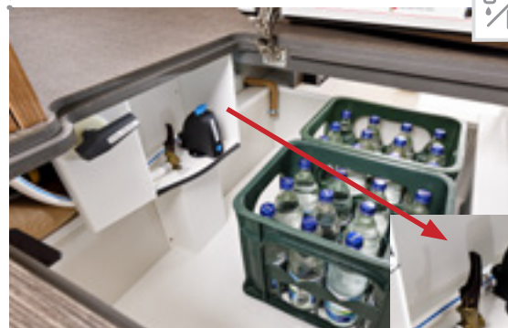
Wasserablasszentrale im Doppelboden-Keller – auch von außen durch die Aufbau-tür bedienbar
